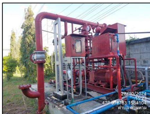
ภาพที่ 23 Fire Pump และ Jockey Pump
