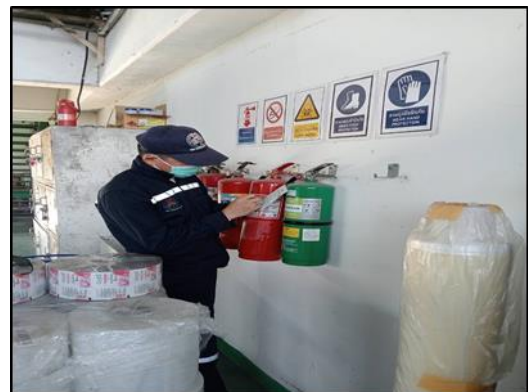
ภาพที่ 34 ตรวจเช็คอุปกรณ์ดับเพลิง
